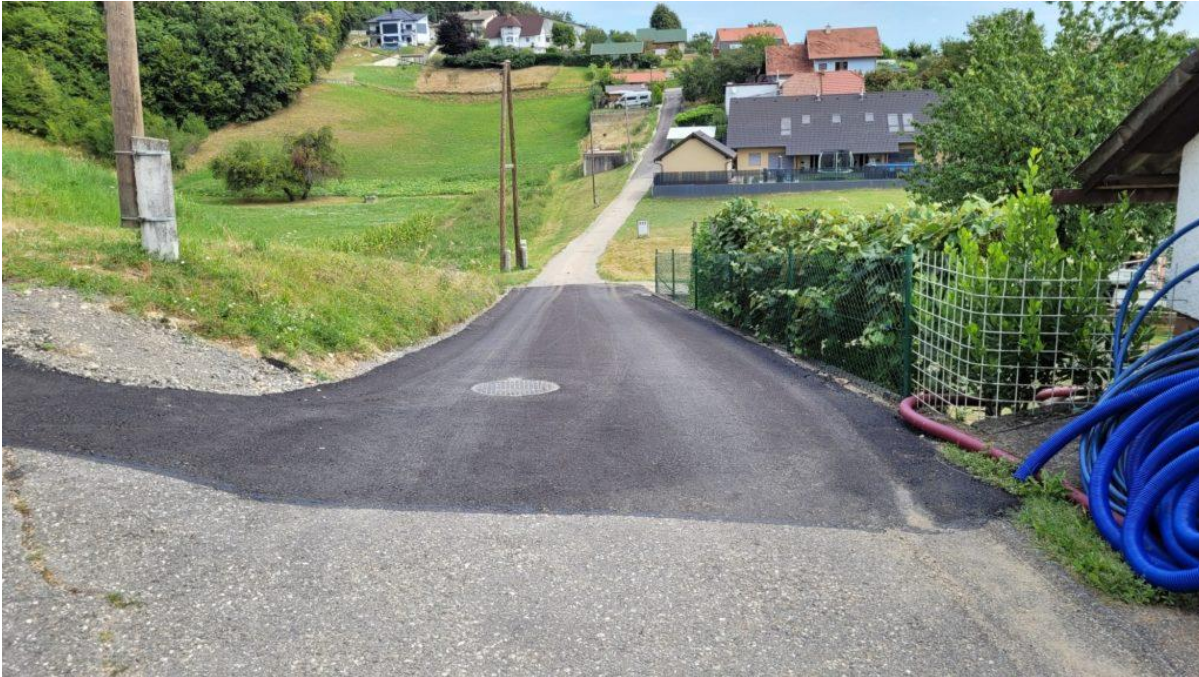
Območje gradnje: JP št. 581170, odsek 581171 Zg. Duplek (Ornik – Kekec); K-3.1.1.
