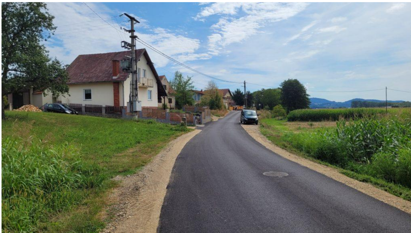
Območje gradnje: LC 081050, odsek 081051 Zg. Duplek - Križ - Talce.
