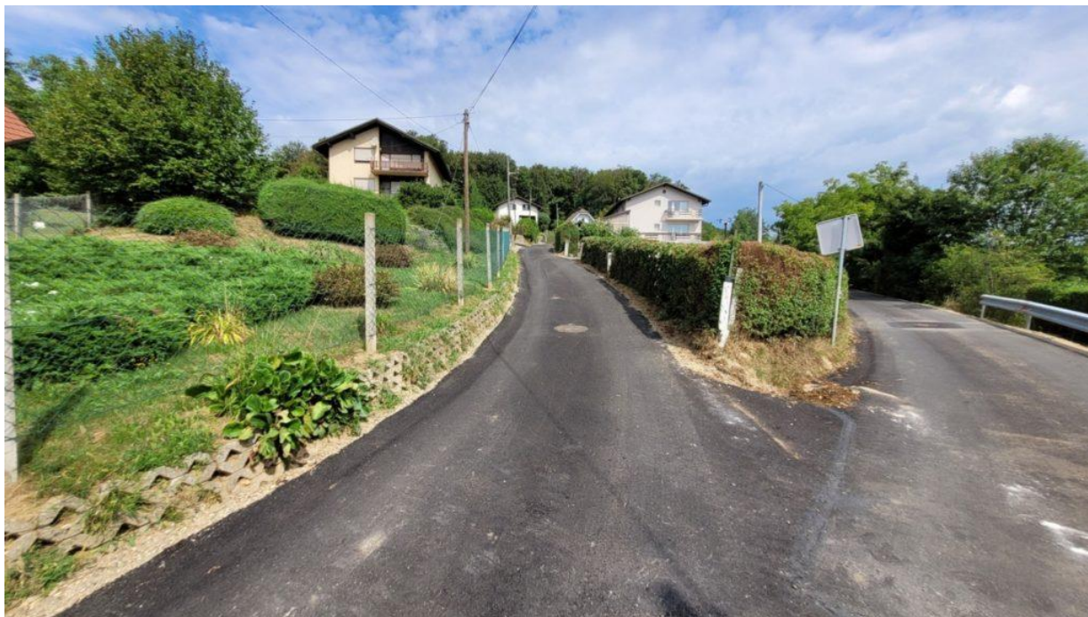
Območje gradnje: JP 581231 - Zg. Duplek (Vajda - Kirali).
